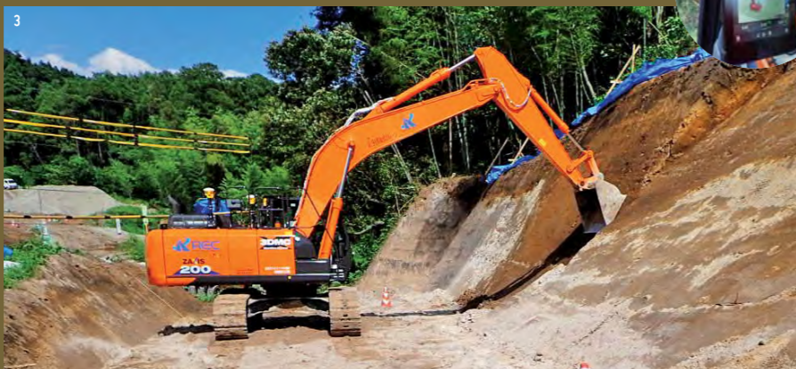
3. ICT施工に対応したZX200X-6によるのり面整形。4. キャブ内のディスプレイに表示された施工図面に沿って作業を行う。5. 東九州自動車道の工事では、橋台を載せる部分が軟弱地質だったために、土を掘ってから土質を改良して埋め戻すという作業を短期間で行う難工事となった。
