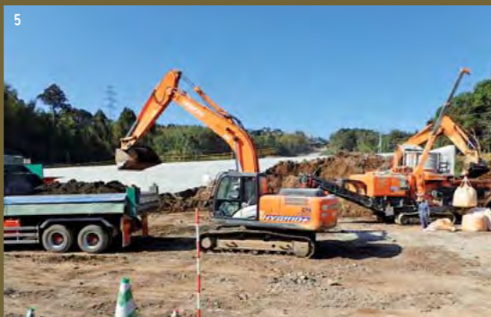
3. ICT施工に対応したZX200X-6によるのり面整形。4. キャブ内のディスプレイに表示された施工図面に沿って作業を行う。5. 東九州自動車道の工事では、橋台を載せる部分が軟弱地質だったために、土を掘ってから土質を改良して埋め戻すという作業を短期間で行う難工事となった。
