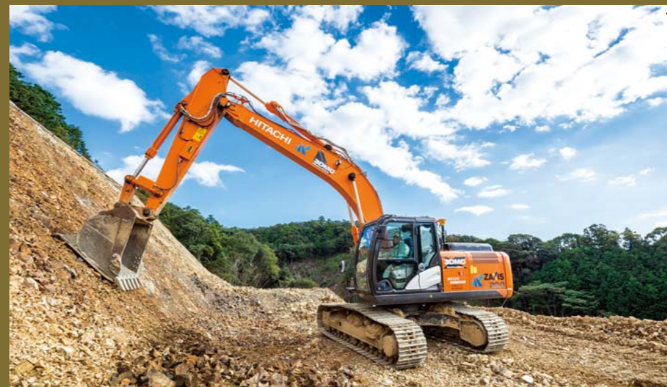
1. すさみ串本道路の有田東地区改良工事現場において、マシンコントロールを装備した日立建機のZX200X-5Bが掘削とのり面整形を行っている。2. 掘削した土砂をダンプトラックに積み込んでいるのは尾花組所有の日立建機ZX200-5B。マシンガイダンス機能を搭載。3. 現在は、主に工事用道路の建設を進めている段階で、ICT施工に対応した4台の建設機械が稼働している。
