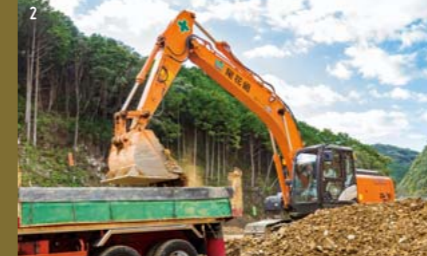
1. すさみ串本道路の有田東地区改良工事現場において、マシンコントロールを装備した日立建機のZX200X-5Bが掘削とのり面整形を行っている。2. 掘削した土砂をダンプトラックに積み込んでいるのは尾花組所有の日立建機ZX200-5B。マシンガイダンス機能を搭載。3. 現在は、主に工事用道路の建設を進めている段階で、ICT施工に対応した4台の建設機械が稼働している。
