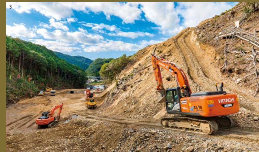
1. すさみ串本道路の有田東地区改良工事現場において、マシンコントロールを装備した日立建機のZX200X-5Bが掘削とのり面整形を行っている。2. 掘削した土砂をダンプトラックに積み込んでいるのは尾花組所有の日立建機ZX200-5B。マシンガイダンス機能を搭載。3. 現在は、主に工事用道路の建設を進めている段階で、ICT施工に対応した4台の建設機械が稼働している。
