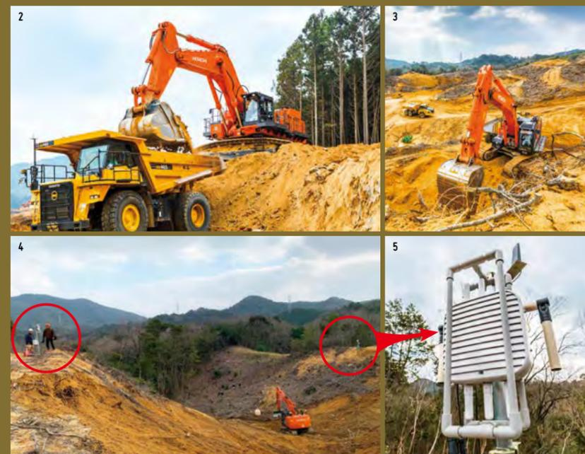
2. この工事のために導入された日立建機の油圧ショベルEX1200が、切土をダンプトラックに積み込んでいる。3. マシンコントロールに対応した日立建機のZX200X。4. Solution Linkage Wi-Fiの親機（右）と子機（左）。この窪地に携帯電話の電波が届かないため、親機と子機で電波を中継することでICT施工が可能になる。電波の届くエリアは約100m。5. Solution Linkage Wi-Fiの親機。携帯電話の電波が届く場所に親機を設置することで通信を確保する。
