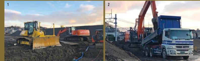
1&2.現場では写真のように複数の機械がそれぞれの作業を行っているが、Solution Linkage Mobileを導入するとダンプトラックの運行状況が各種建設機械からもリアルタイムに把握でき、積み込みタイミングを見計らいながらスムーズな作業段取りを立てられる。3.油圧ショベルに設置されたモバイル端末。直感的インタフェースなので操作も簡単。
