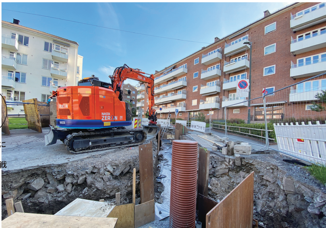
ノルウェー・オスロのゼロエミッション建設サイトパイロット事業の工事で稼働する「ZE85」
