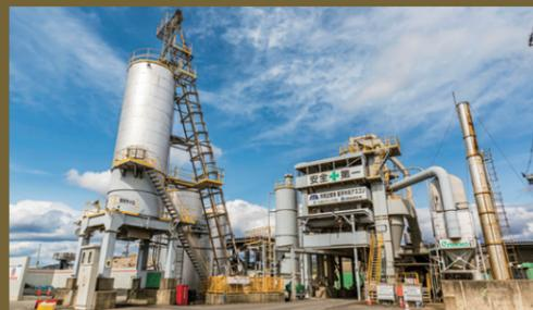
施設内の中央に設置されているアスファルト合材の生産設備。今や出荷量の9割が再生アスファルトになっている。
