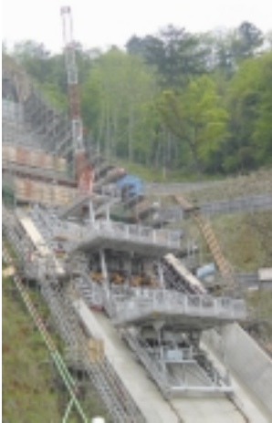
建設作業用インクライン
