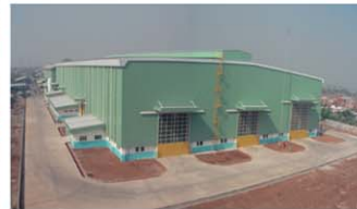
P.T.日立建機インドネシア チビトン工場 超大型油圧ショベルの製缶工場 として本年10月から操業開始。
