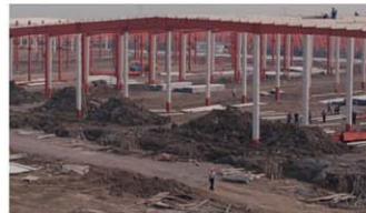
合肥日建機工有限公司 切り板加工工場を建設中。 ('08年5月稼動予定)
