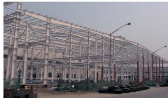
日立建機（中国）有限公司 製缶工場を増築中。 ('08年4月稼動予定)
