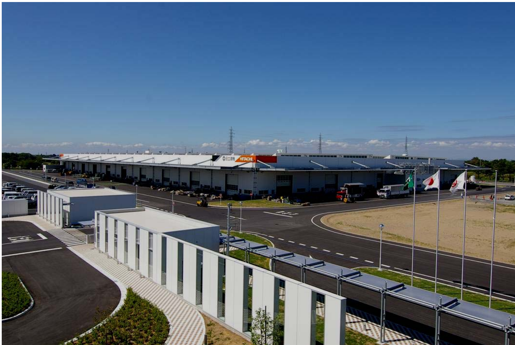
完成した常陸那珂工場(8月29日竣工)
