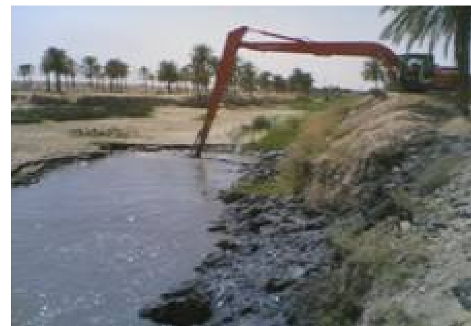
イラク向けスーパーロングフロント 稼動現場
