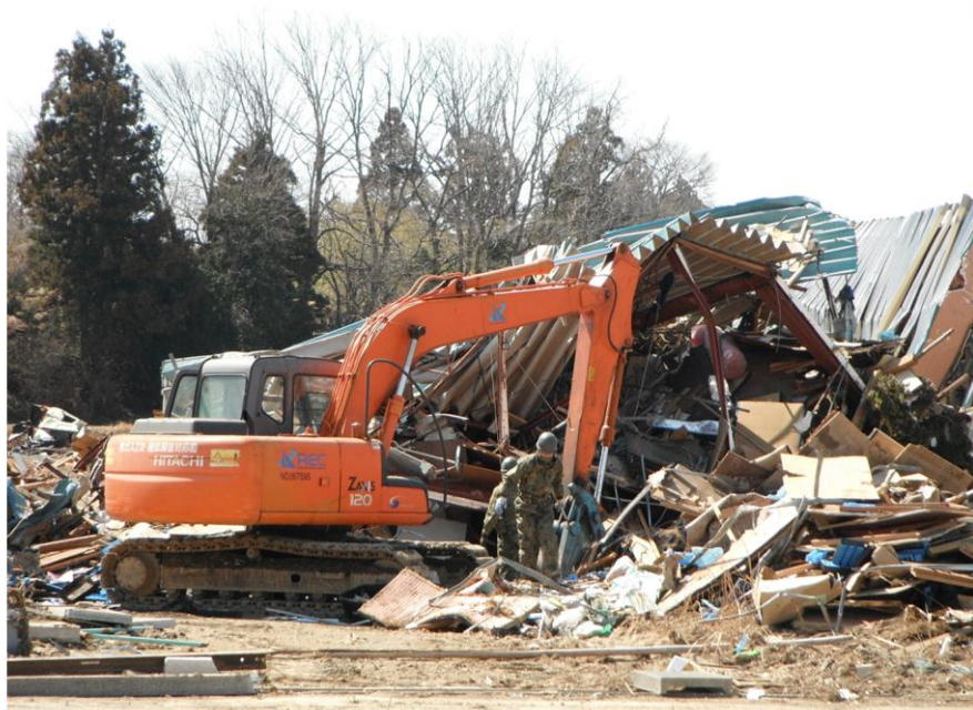
被災地で稼動するZX120
