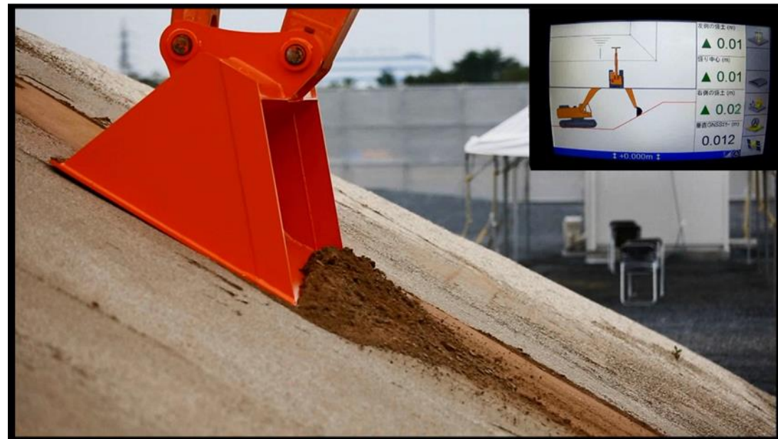
マシンコントロール機による半自動運転の様子
