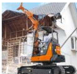
木造家屋 解体
