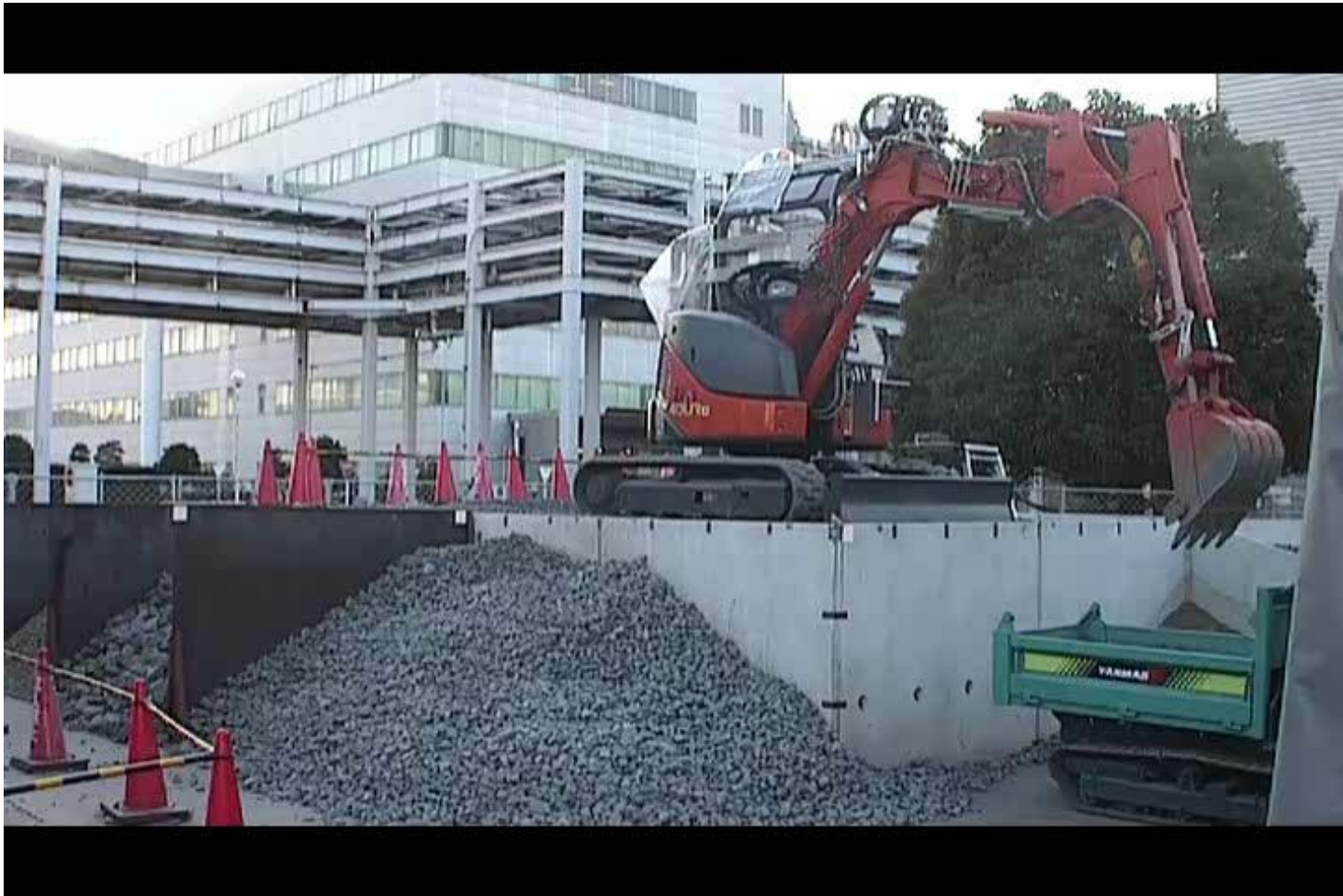
ミニショベルの自動掘削積み込み試験
