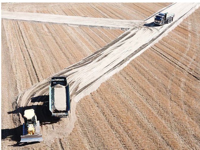
SL-Mobileを使ってダンプトラック12台を管理した
