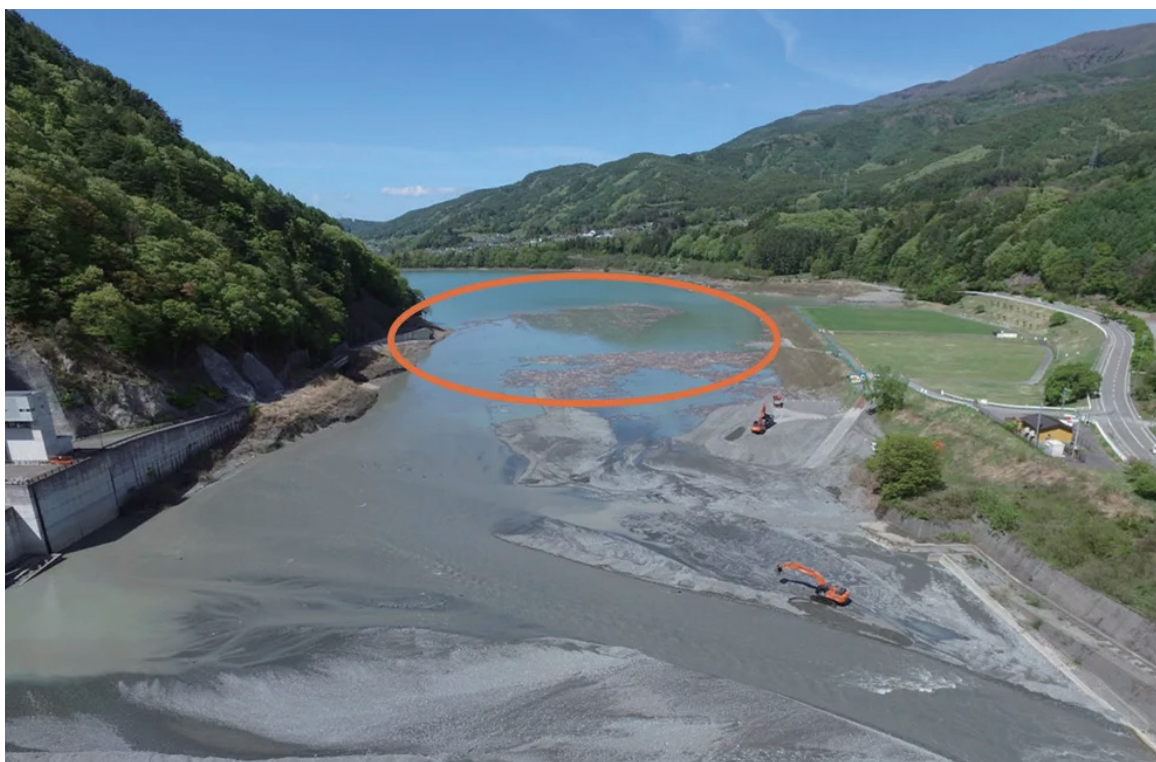
ダム湖面に堆積した流木
