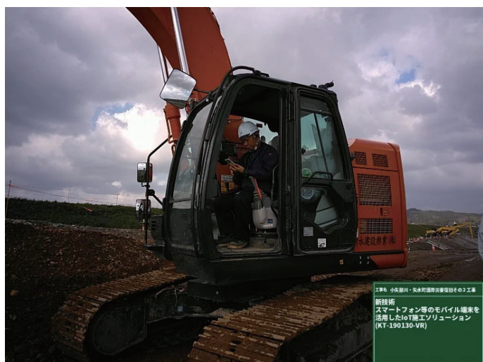
重機オペレータへのスマートフォン配布
