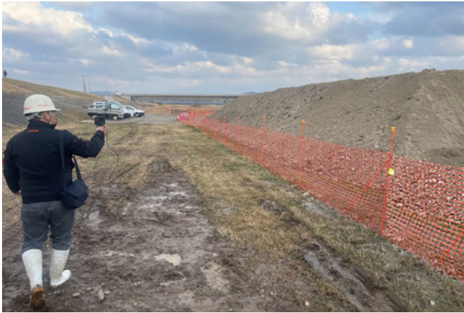
Solution Linkage Surveyによる土量計測の様子
