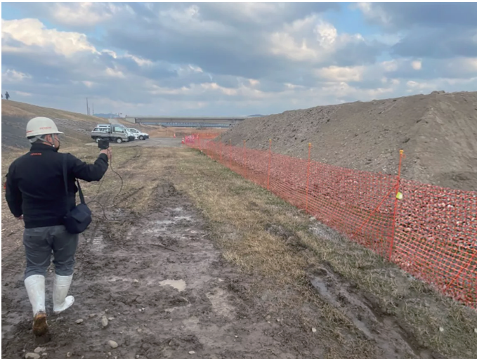
Solution Linkage Survey による土量計測の様子
