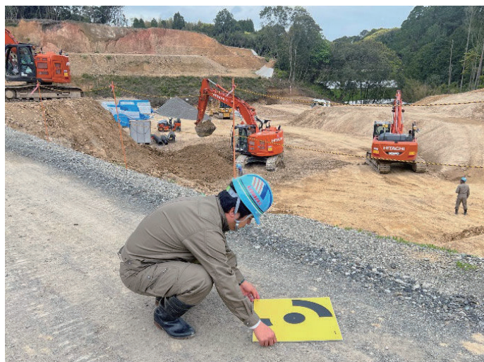
対空標識設置 / 計測
