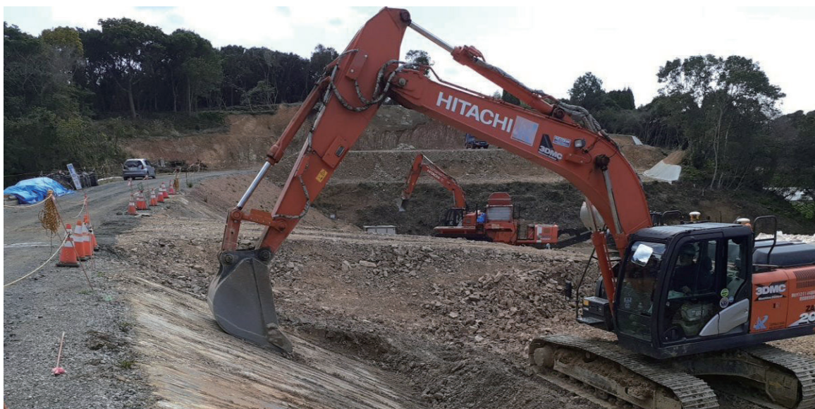
ICT 建機による切土法面整形
