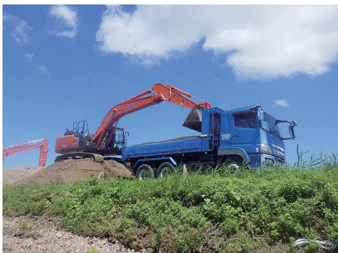
車載カメラ付きショベルで積込作業
