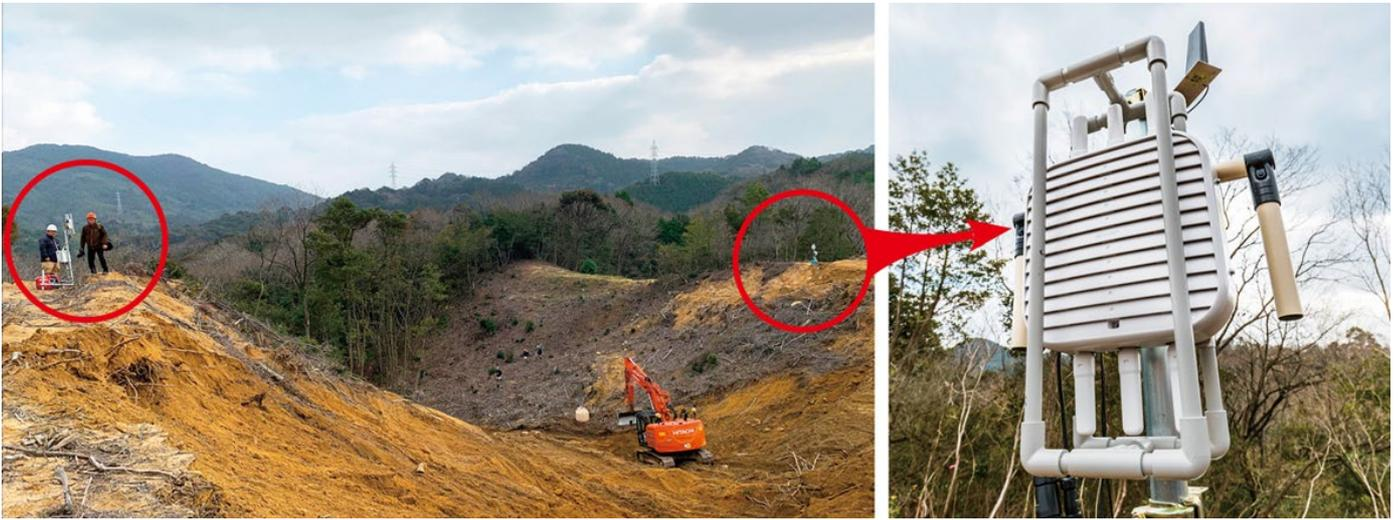
左. Solution Linkage Wi-Fiの親機（右）と子機（左）。この窪地に携帯電話の電波が届かないため、親機と子機で電波を中継することでICT施工が可能になる。電波の届くエリアは約100m。
