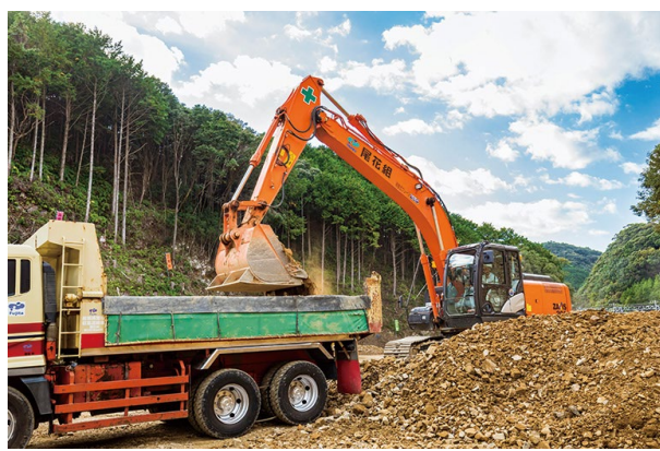
掘削した土砂をダンプトラックに積み込んでいるのは尾花組所有の日立建機ZX200-5B。マシンガイダンス機能を搭載。
