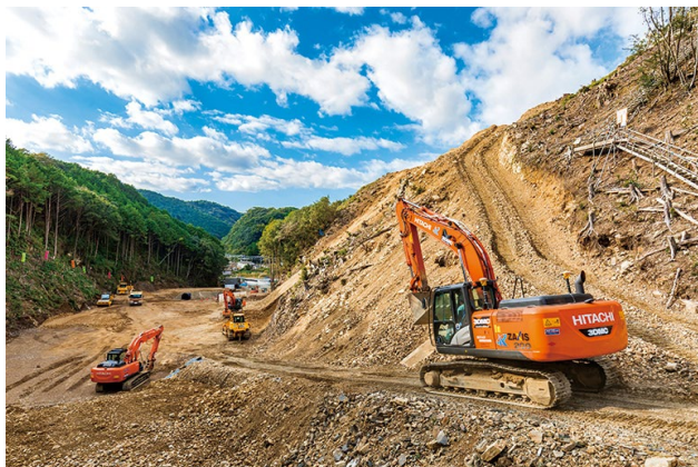
現在は、主に工事用道路の建設を進めている段階で、ICT施工に対応した4台の建設機械が稼働している。
