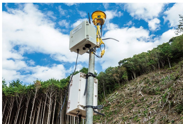
GNSS基準局のアンテナから、ICT建機の受信機に位置情報に関するデータが送られる。
