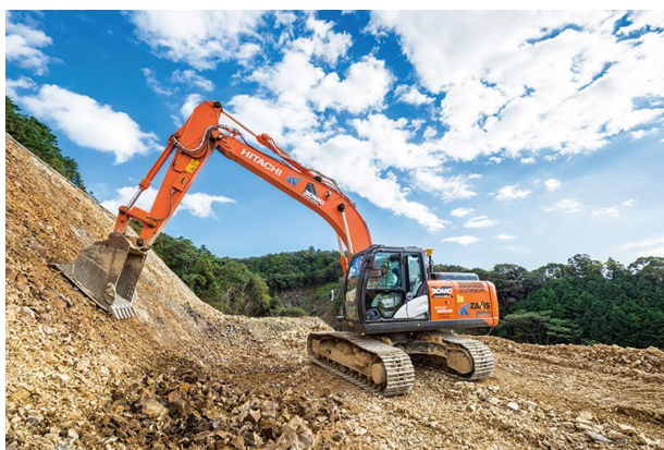
すさみ串本道路の有田東地区改良工事現場において、マシンコントロールを装備した日立建機のZX200X-5Bが掘削とのり面整形を行っている。
