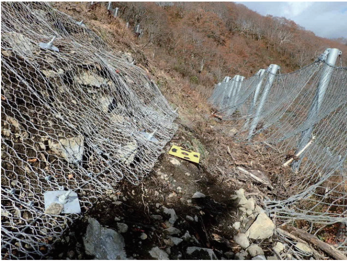
対空標識の設置
