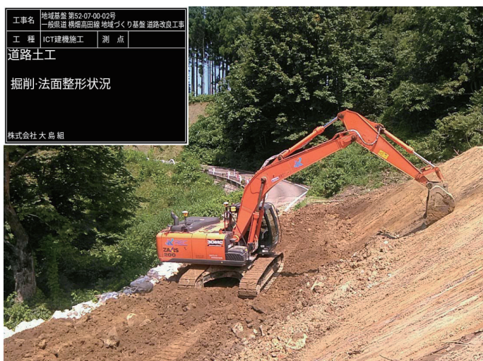
丁張なしで進む法面施工
