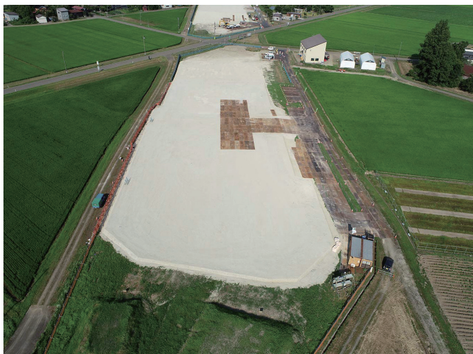
ICT 施工による盛土工事の完了
