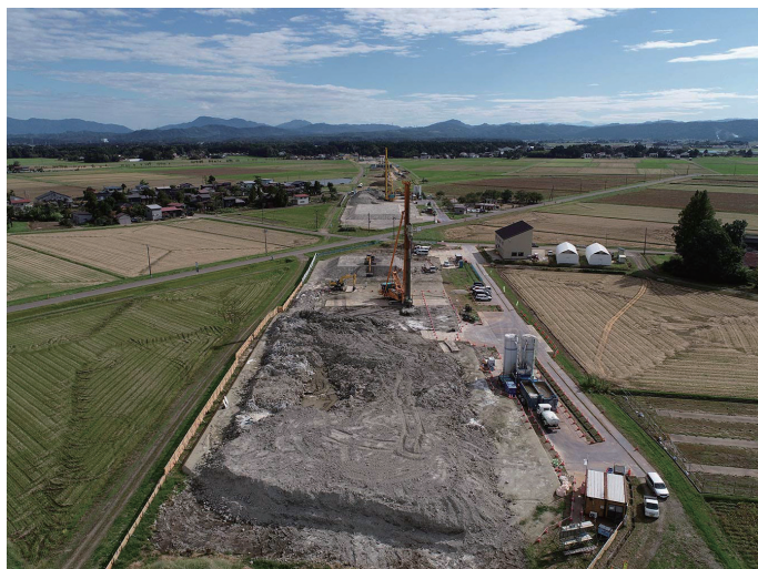
地盤改良工事中の現場
