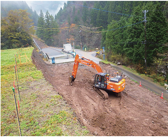
国道439号線の道路改良工事で活躍するZX200X。3次元設計データと衛星位置情報に基づくリアルタイムなマシンコントロールが効果を上げた。
