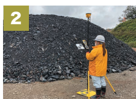
対空標識の設置・計測
