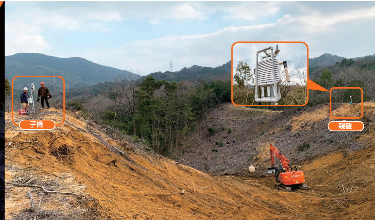
Solution Linkage Wi-Fiの親機(右)と子機(左)。 山間部などの携帯電話の電波が届かない現場では、電波を中継することでICT施工が可能になります。
