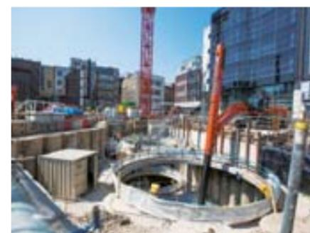
ロンドンの地下鉄トンネル掘削工事で稼働する「ZCX350LC テレスコピックラムシェル仕様機」
