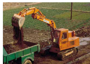
1965年 純国産技術による国内初の油圧ショベル「UH03」を製品化
