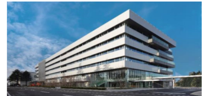
新たに建設されたエンジニアリング棟(茨城県土浦市)の外観
