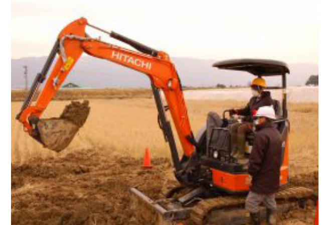
ミニショベルによる復旧作業の実技講習（福岡県朝倉市）
